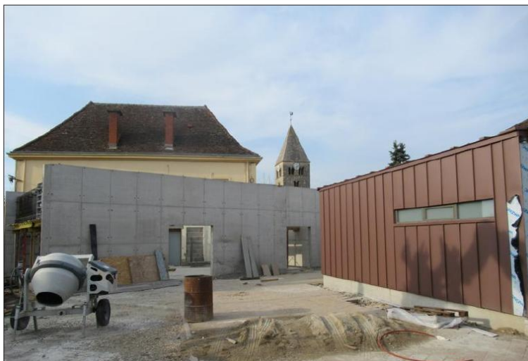
Encore quelques mois à patienter avant la fin des travaux de la mairie. Photo JSL/Guy CATTIN
